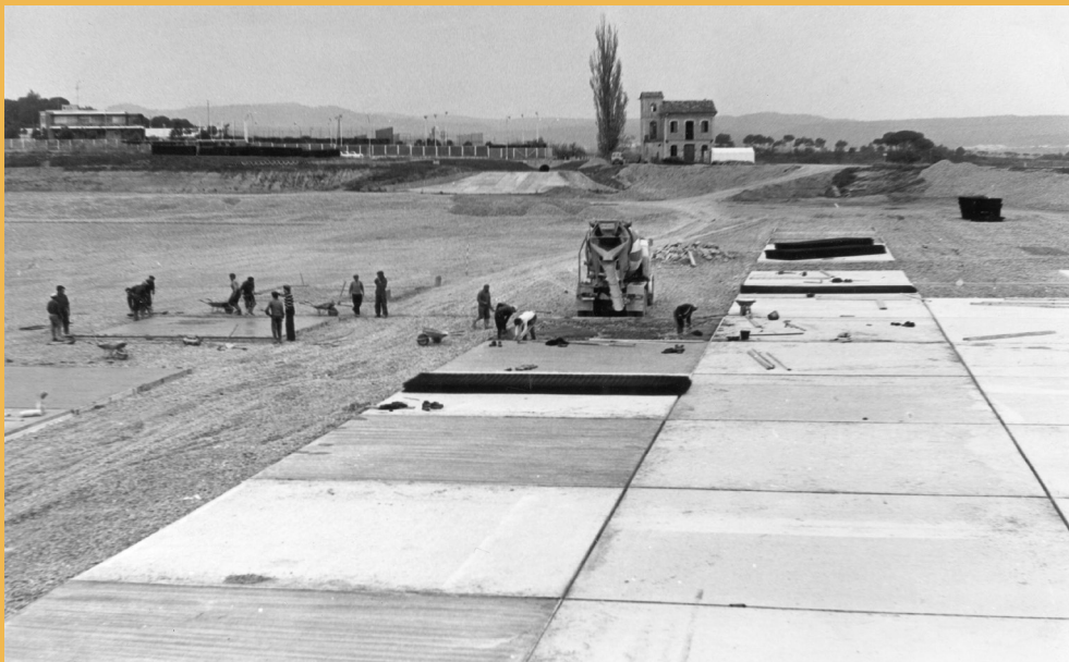
Obres d'impermeabilització del fons de l'embassament de l'Agulla (maig de 1974). Fotografia: Berengueras (Arxiu Comarcal del Bages. Fons Ajuntament de Manresa, uc. 5406)
