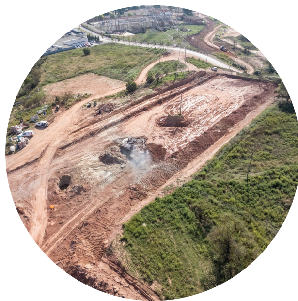
PI Pont Nou II
